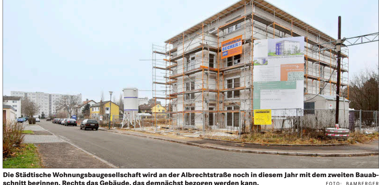
Die Städtische Wohnungsbaugesellschaft wird an der Albrechtstraße noch in diesem Jahr mit dem zweiten Bauabschnitt beginnen. Rechts das Gebäude, das demnächst bezogen werden kann.
